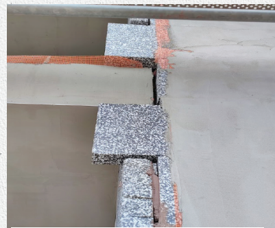
Широка фуга запълнена с лепило
