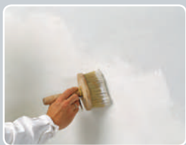
Нанасяне на Putzgrund
