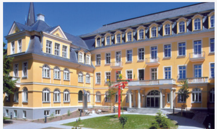
St.-Elisabeth-Krankenhaus, Halle, renoviert mit Histolith Außenquarz
