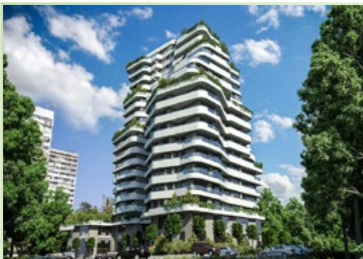
Жилищна сграда Flora Residence, гр. Бургас Топлоизолационна система Minera Line
