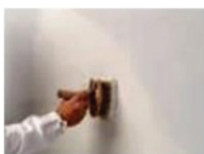
Нанесете грунд с четка
