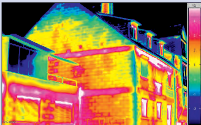
Imaginea 1. Prin tehnica termografiei, pierderile de căldură sunt evidențiate de suprafețele roșii.
