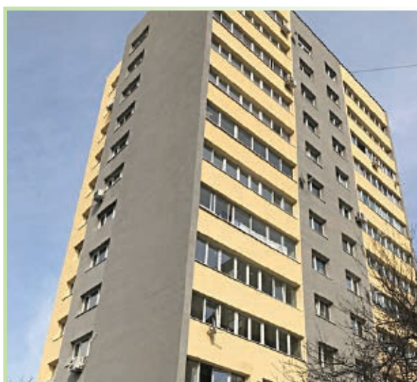
Жилищна сграда, Габрово – Система DALMATINA, Silicat Fassadenputz K15
